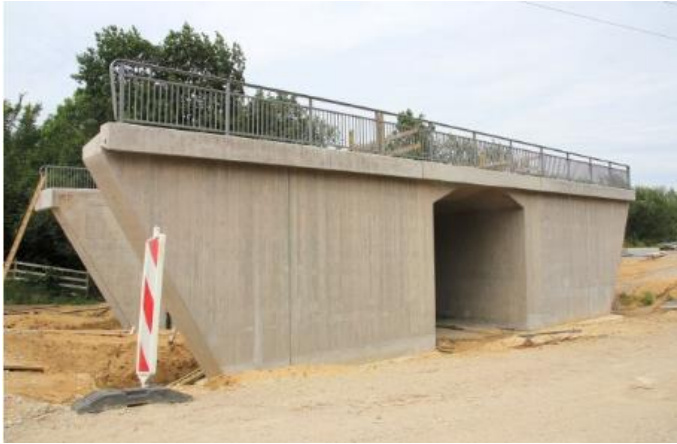
Der Rohbau für die Unterführung in der Nähe des Hafens Foto: Andreas Daebeler / HA
