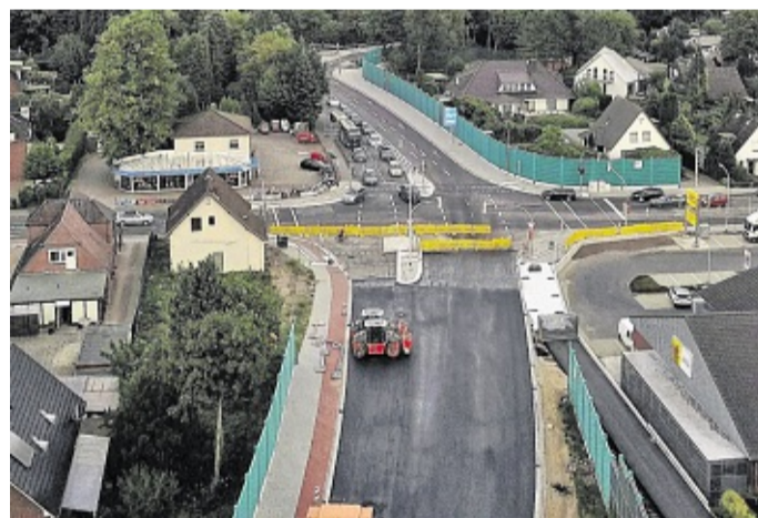
Seit Ende August ist die Westumgehungs-Anschlussstelle Elmshorner Straße nun asphaltiert.
