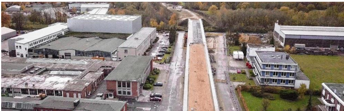
DIE BRÜCKE STEHT SCHON: DER LETZTE TEILABSCHNITT SOLL IM SEPTEMBER FREIGEgeben WERDEN. HANS-JOACHIM KÖLLN
